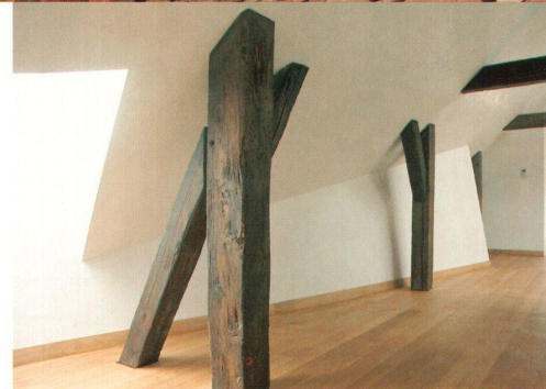
^ Roh gegipste Flächen decken die Dämmung ab, dazwischen stossen die Balken hervor.
