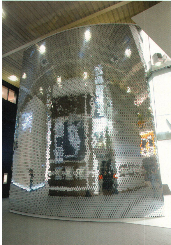
^Die komplette Wand besteht aus 16 000 Aluschuppen, die sich einzeln und geräuschlos bewegen lassen.
