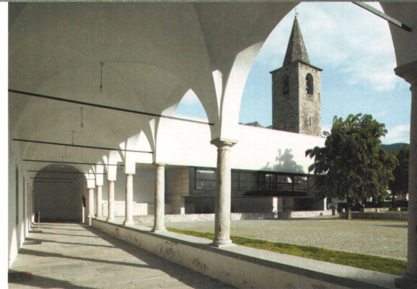
> Blick in die Zugangsgalerie und auf das halbe Tonnendach.
