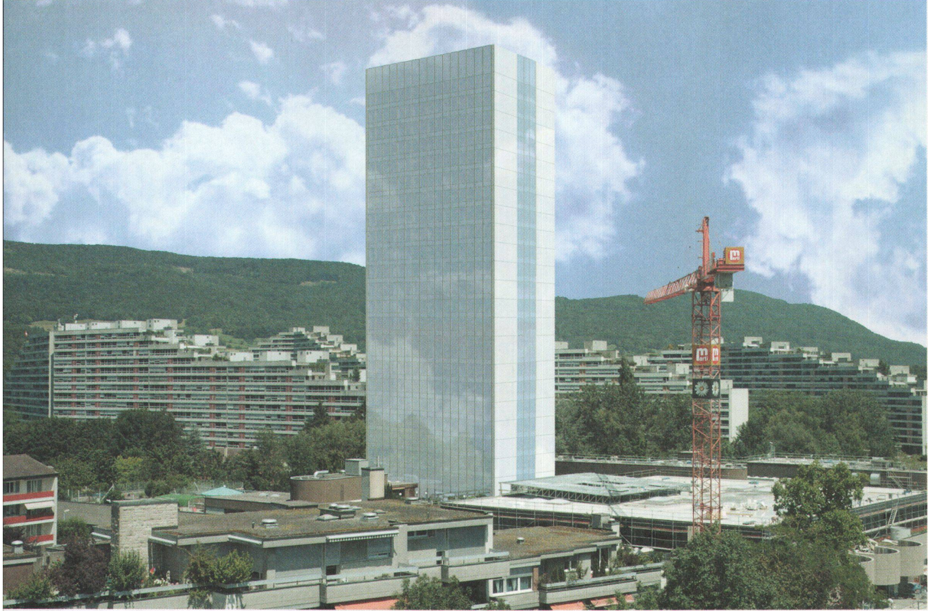
^6_ Erneuerung Gebäudehülle Telli-Hochhaus
