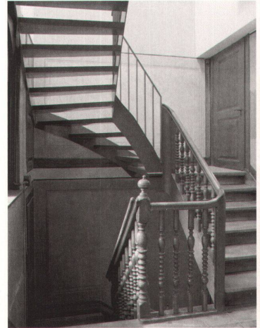
^ Ein scharfer Schnitt: Eine Stahltreppe setzt den Weg nach oben fort.
