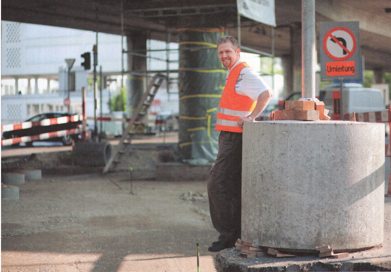
^Bändigt am Escher-Wyss-Platz das Baustellendurcheinander: Arthur Müller, Chef der Fachgruppe «Temporäre Verkehrsanordnungen».
