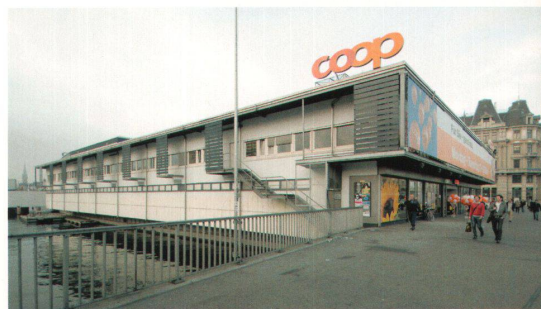
> Die stärkste Seite des Gebäudes: die Flussseite mit der eleganten Auskragung.
