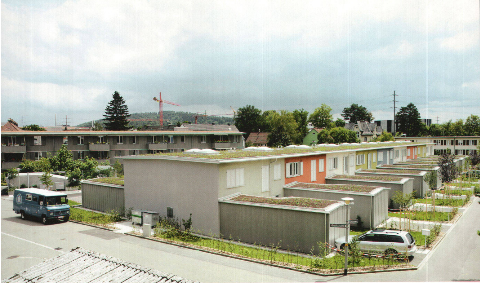
^ Das Farbkonzept der Architekten lockert den Stadtrain in Winterthur wohltuend auf. Gut sichtbar sind auf dem Dach die erweiterten Oblichter. Im Hintergrund der Ersatzneubau mit altersgerechten Wohnungen.
