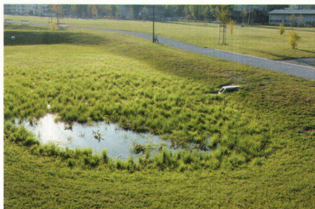
> Das Dachwasser der nahen Siedlung sammelt sich in den Retentionsbecken.
