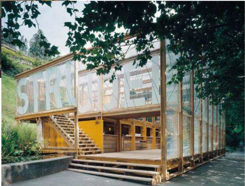
> 40_Pavillon Strudel, Baden: zusammengebaut aus Baustellenabfall
