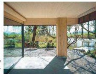
➤55_Sommerhaus: einer von acht massiven Lärchenpfählen.
