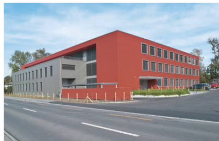
< Vogelwarte-Neubau mit Solarzellen auf dem Dach und einer Holzschneitzelheizung im Keller.
