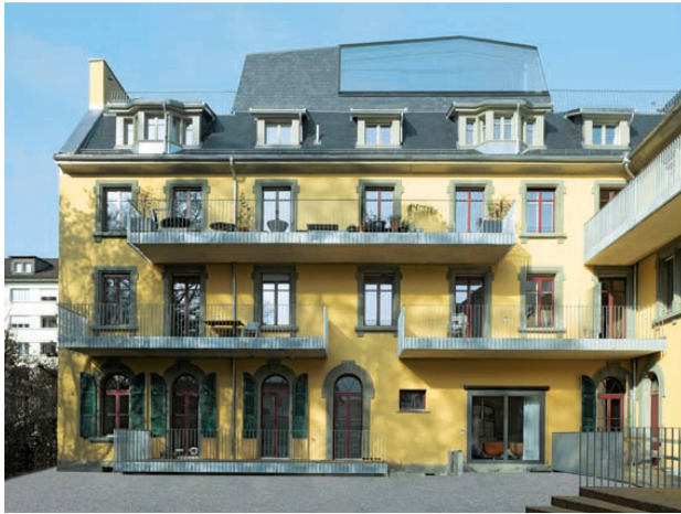
<Sichtbare Eingriffe: Neue Balkone und ein Aufbau, der im Dachstock Platz schafft und Licht hineinbringt.
