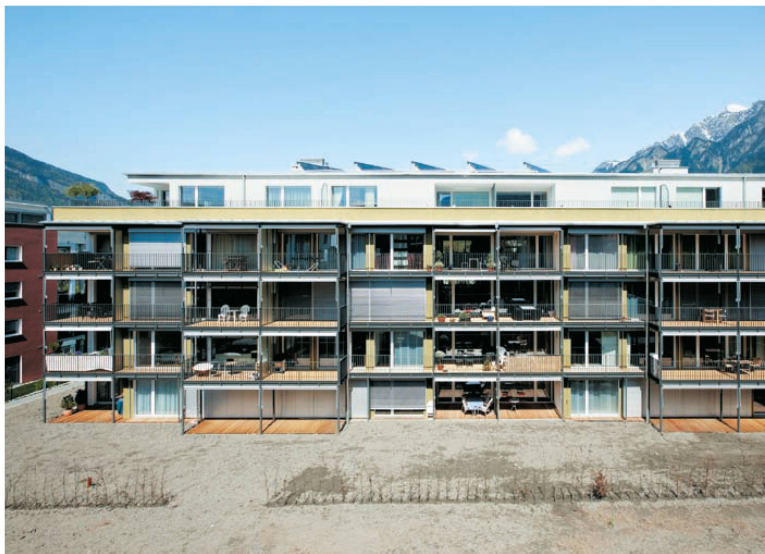
> Mehrfamilienhaus Segantini in Chur. Eine gemeinsame Initiative eines Architekten und eines Baumeisters.
