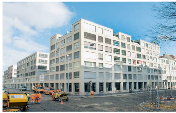
<12_Sabag-Areal: Die Fortsetzung des Stadtmusters des Roten Biel heute: ein städtischer Blockrand mit grossem Innenhof. Foto: Peter Samuel Jaggi
