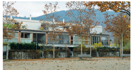
v10_ auf dem Renferareal waren Wohnungen für den Mittelstand das Ziel. Foto: Peter Samuel Jaggi
