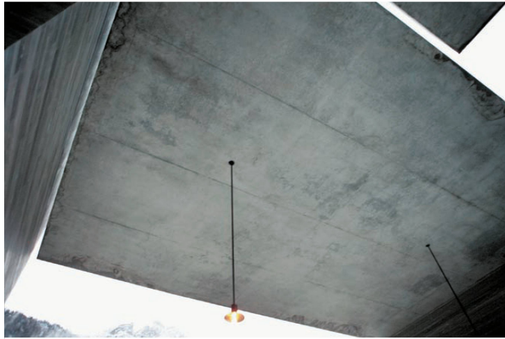
^Die Deckenplatten kragen zum Teil weit aus.
