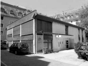
^ Das Haus vor dem Umbau.
