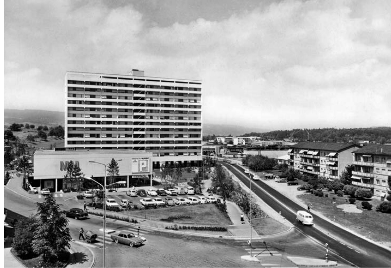
^Nicht im Zentrum, sondern am Ortsausgang haben die Sechzigerjahre das markanteste Zeichen gesetzt: das Wohnhochhaus am Kesslerplatz. Rechts die noch nicht ausgebaute Badenerstrasse. Postkarte
