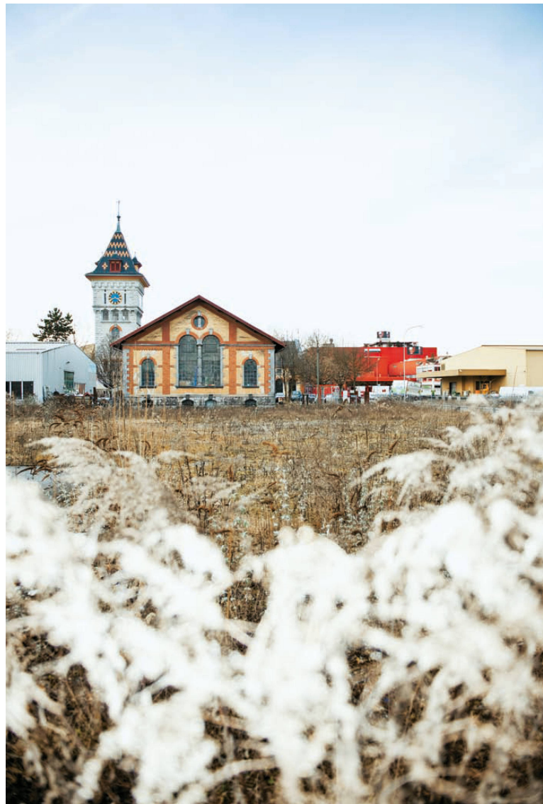
^Der Wasserturm und das Uhr- und Reglerhaus sind zwei Zeugen aus der Anfangszeit des Gaswerks der Stadt Zürich. Darum herum hat sich seit der Einstellung der Gasproduktion vieles verändert.
