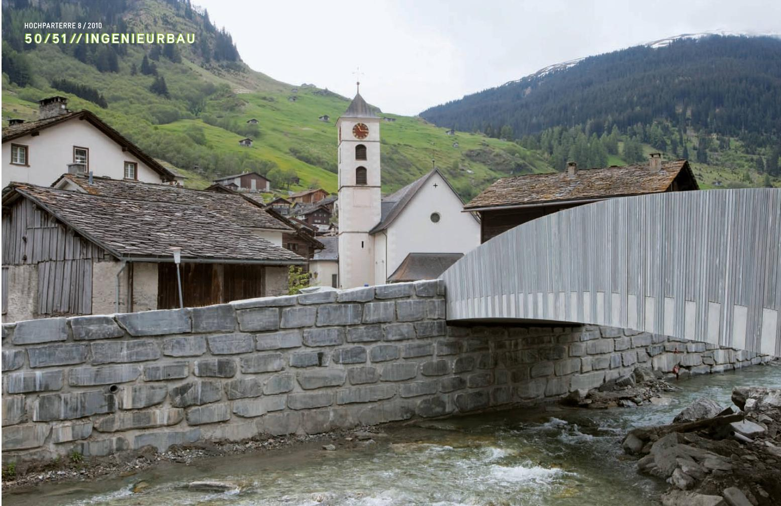
^Ein Stein, zwei Zustandsformen: Fein und scharfkantig bei der Brücke, wuchtig und unregelmässig bei der Mauer.
