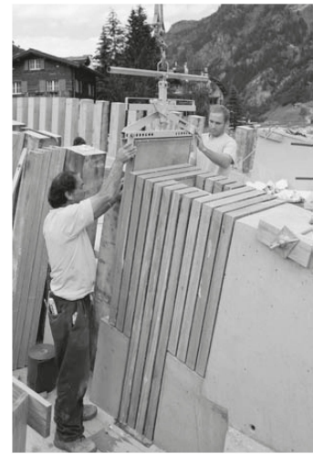
^Die 64 Millimeter starken Steinplatten umschliessen die leicht konischen Betonpfeiler.
