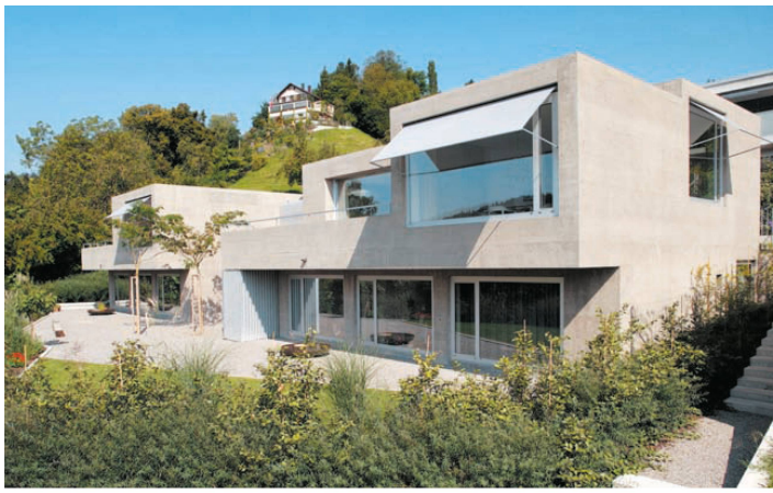
◀Nicht nur Fassade: Die Betonkonstruktion des Doppelhauses in Winterthur trägt, dämmt und stabilisiert den Hang.
