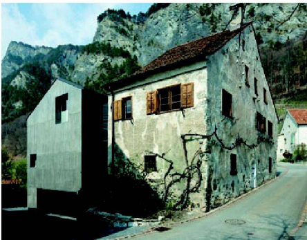
<Alt und Neu in der Casascua von Architekt Kurt Hauenstein.
