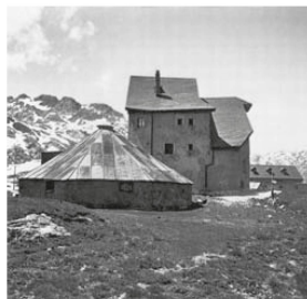
< Vor dem Umbau deckte ein niedrigeres Dach den hinteren Teil mit Kapelle.
