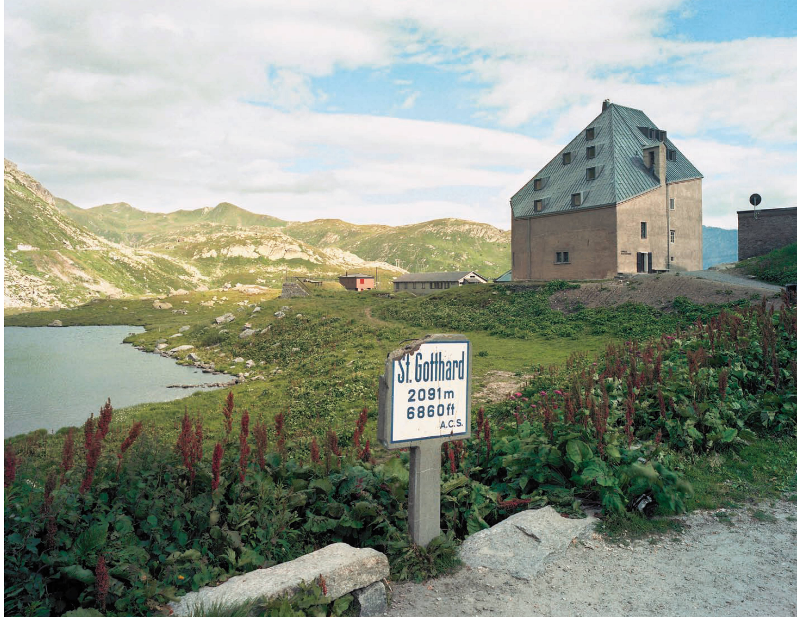
^ Dominiert die Passhöhe: das umgebaute Hospiz. Auf der Nordseite zieht sich die grosse Dachhaube tief hinunter.
