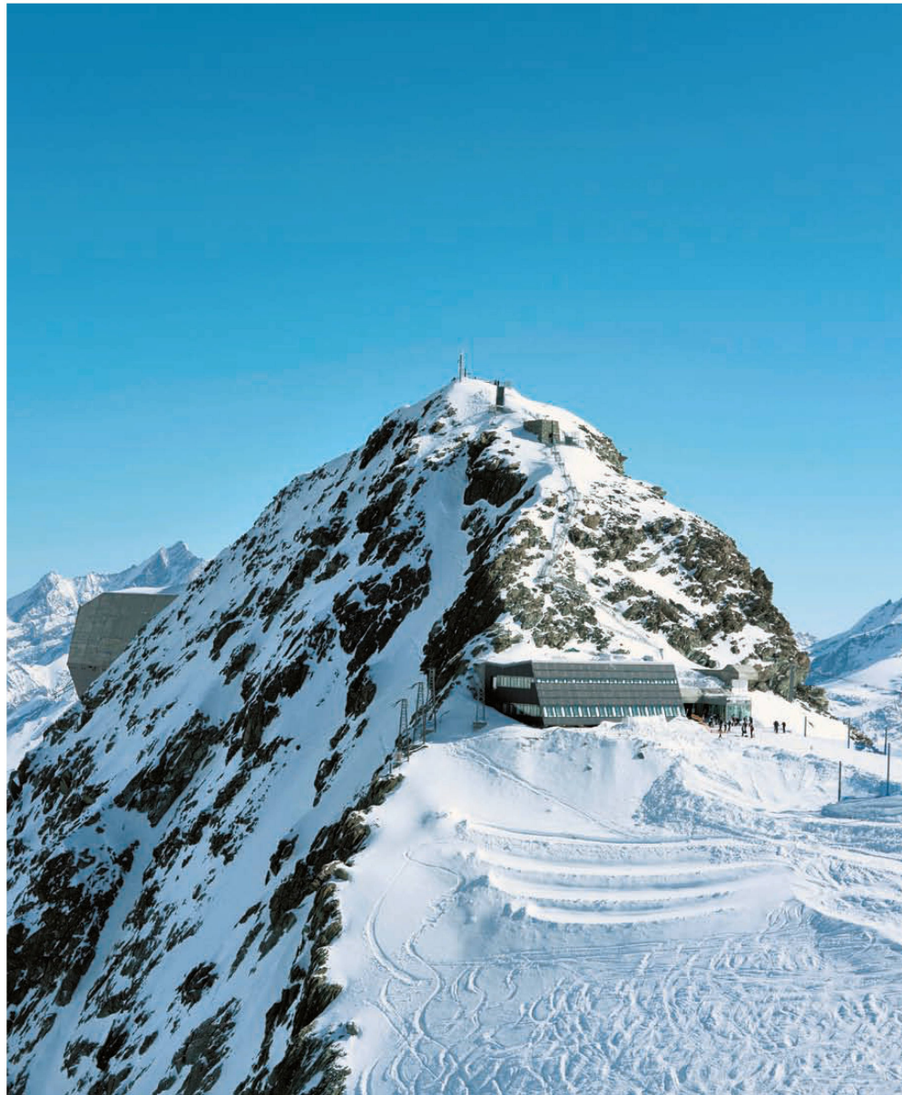
^ «Glacier paradise», das Restaurant der Zermatt Bergbahnen auf dem kleinen Matterhorn, 3883 Meter über Meer, erhält eine Auszeichnung. Sonnenkollektoren und integrierte Fotovoltaikanlagen liefern die gesamte Energie.
