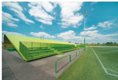
> Das Garderobengebäude wächst aus dem Boden heraus und dient im unteren Bereich als Tribüne.
