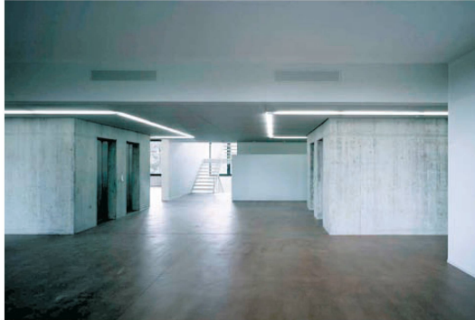
^Am Boden von Gängen und Büros liegt ein rotbrauner Holzzement, in der Eingangshalle und bei den Liftvorplätzen ein geschliffener Gussasphalt.
