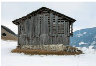
<Die verwitterte Fassade hat viel gesehen.
