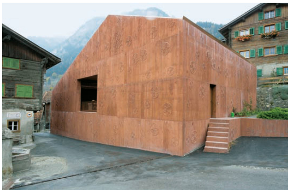
^11_Scharans: Stall weg, ein Neubau ist besser. Architektur: Valerio Olgiati, Foto: Alexander Jaquemet
