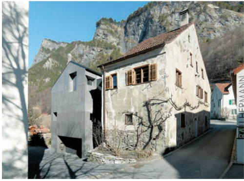
<6_Fläsch: Casascura, der Erweiterungsbau aus schwarzem Beton ersetzt den Stall. Architektur: Kurt Hauenstein, Foto: Ralph Feiner
