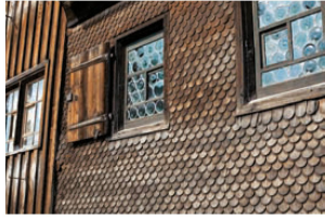
^21_Butzenfenster und Schindelbeschlag, die typischen Attribute.
