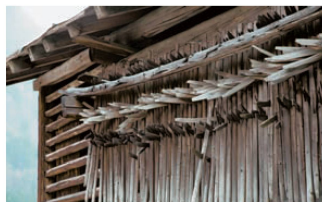
<23_Heinzengerüst am Heulager.
