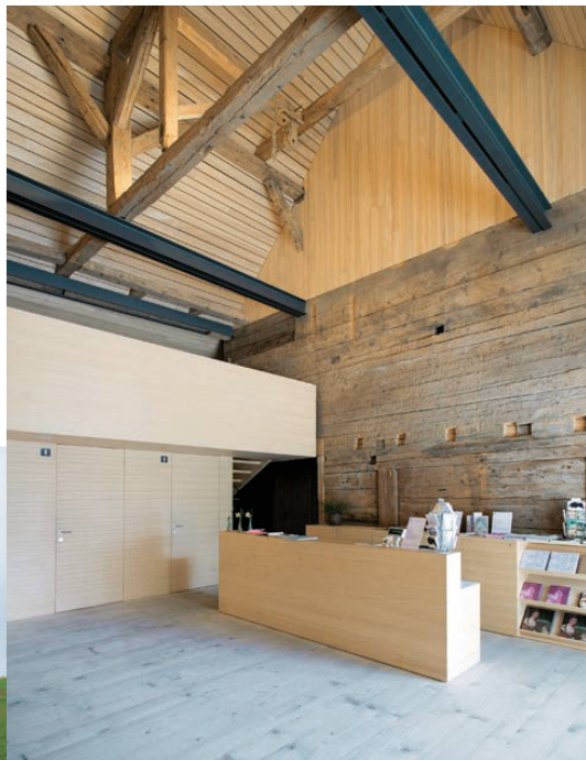
<21_Der Heustall, Stahlträger verstärken die Holzbalken.
