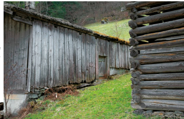
>23_Montafoner Ensemble mit Stall und Heulager.
