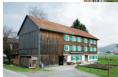
<Andelsbuch: Haus Nr. 154, der Wohntrakt wurde nachträglich zum Stall hin erweitert.
