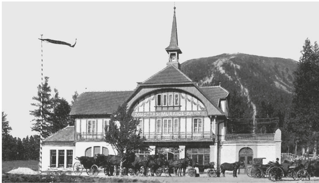
> Bijou aus der Pionierzeit: die Talstation der Muottas- Muragl-Bahn von 1907.
