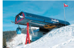
< Modul für überall: Die Bergstation der Gondelbahn Hochstuckli in Sattel SZ.
