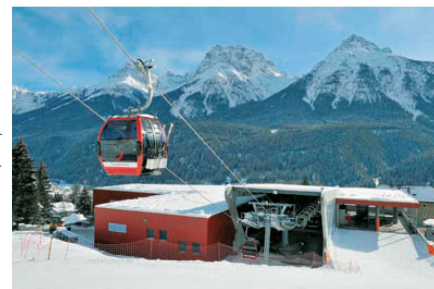
>Truckli im Tal: die Talstation der Gondelbahn Motta Naluns in Scuol GR.
