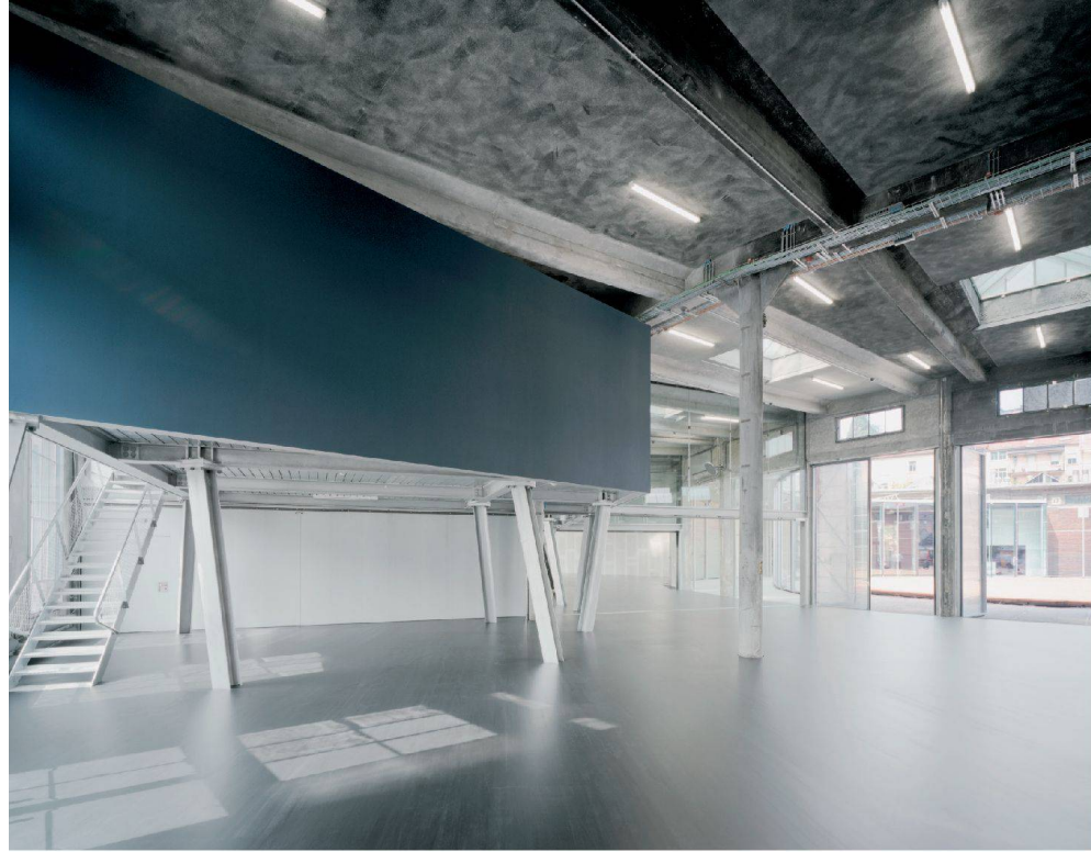
^Die aufgeständerte Box birgt die Garderoben und die Maske des Theaters. Schräge Stützen stabilisieren die Stahlkonstruktion. Der durchgehende Bühnenboden macht die gesamte Theaterzone frei bespielbar. Foto: Walter Mair
