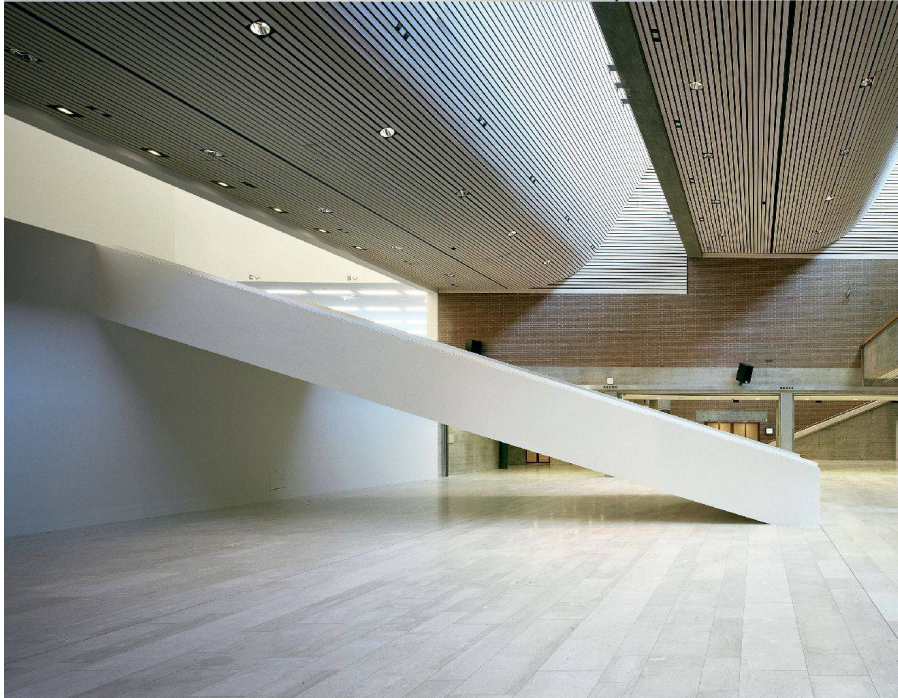
^Der ehemalige Kongresssaal ist nun das Foyer mit einem grosszügigen Abgang von der neuen Wandelhalle.
