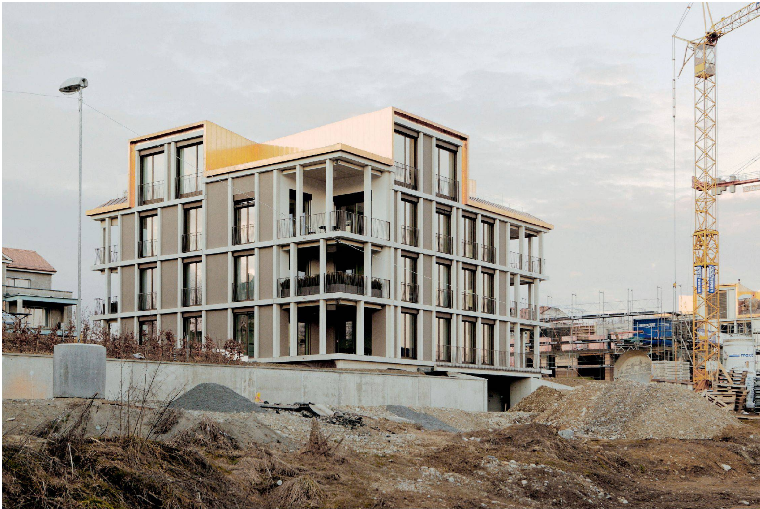
^Graber Pulvers Gebäude nennen wir «Milano».
