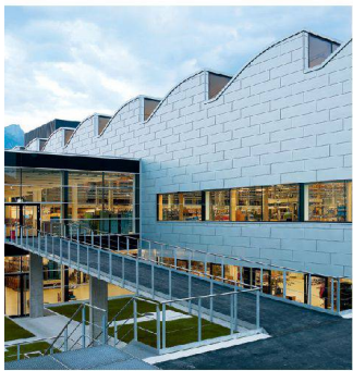
^Der Übergang zum Altbau. ^The passage to the old building.
