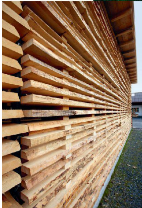
<Unbehandelte, aufgestapelte Bretter als Rückwand. <The back wall: untreated stacked wooden boards.
