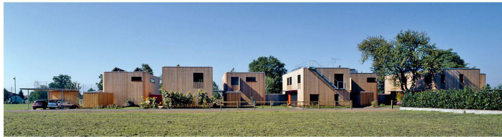
^Die sieben Häuser bei Wolfurt als Einheit. ^A residential estate consisting of seven houses near Wolfurt.
