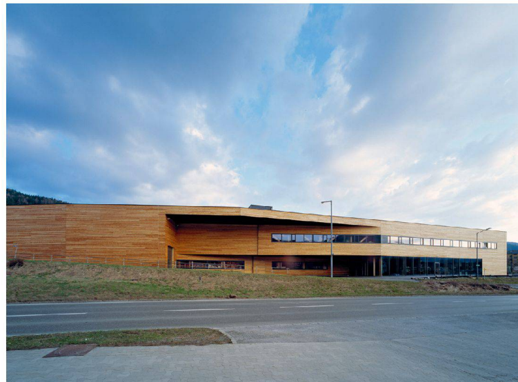
^Das Lärchenholz des Verwaltungsgebäudes in Niklasdorf fällt auf.
