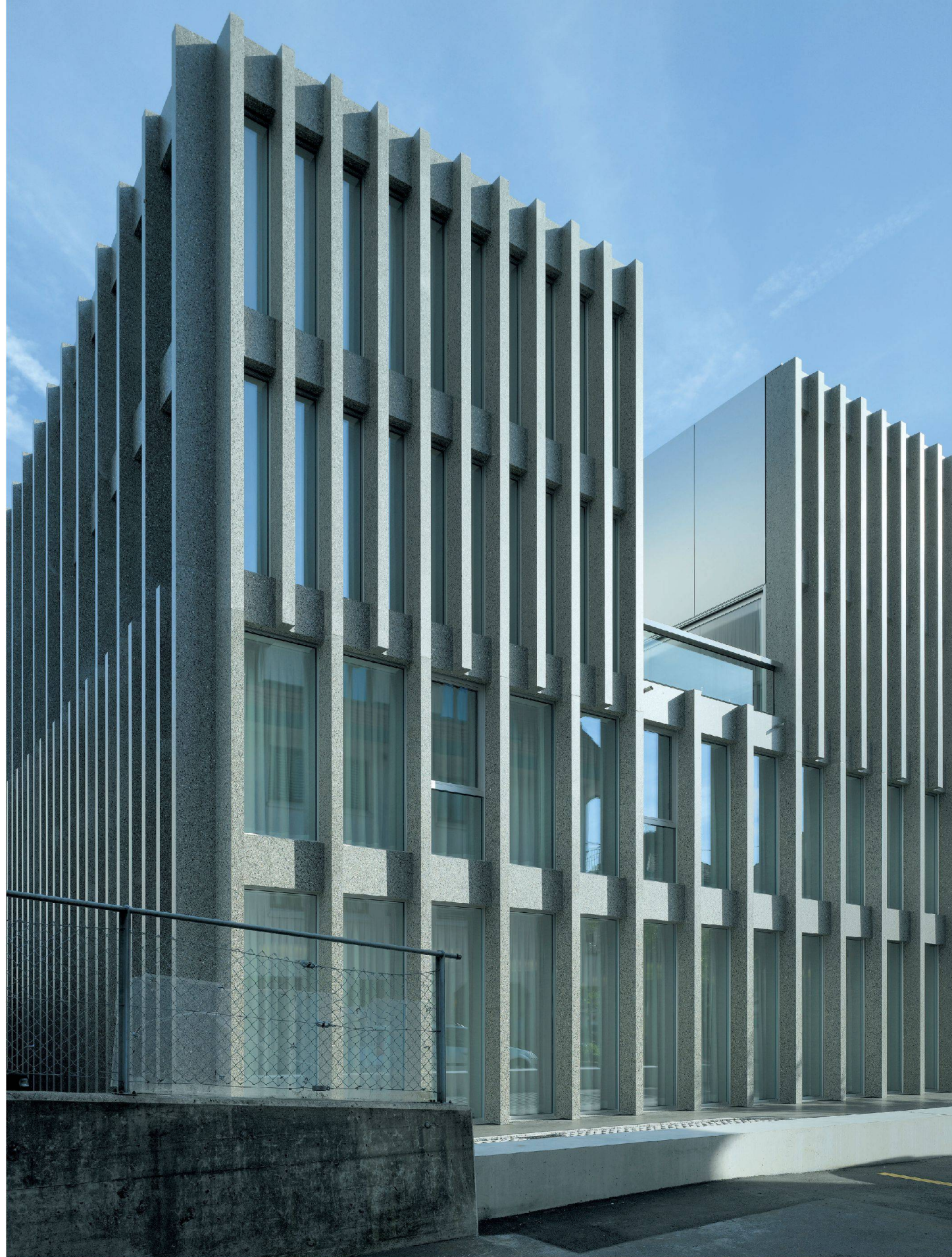
^Raiffeisenbank Küssnacht: Der starke Auftritt kippt beim Einschnitt und an der Ecke.
