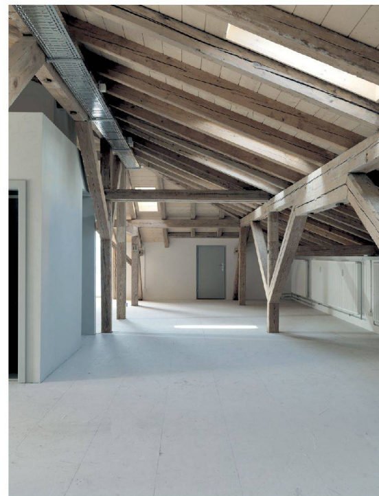
^ Der ausgebauter Dachstock.
