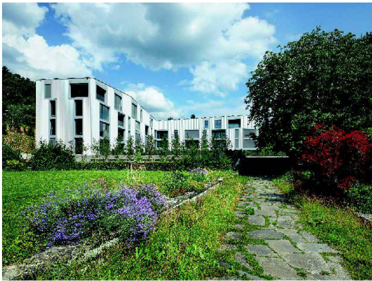
^Wellblech am Zürichberg? Der Schein trägt, die weisse Haut des Baus von EM2N ist aus Holz.
