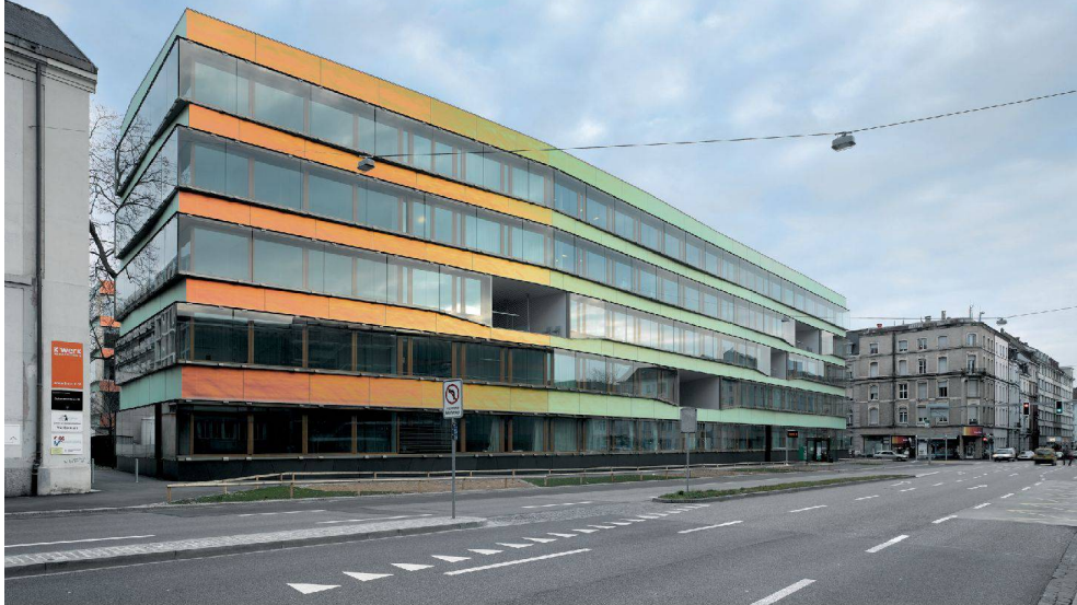
^Fährt man am Kinderspital in Basel vorbei, wechselt die Fassade wie ein Chamäleon die Farbe.
