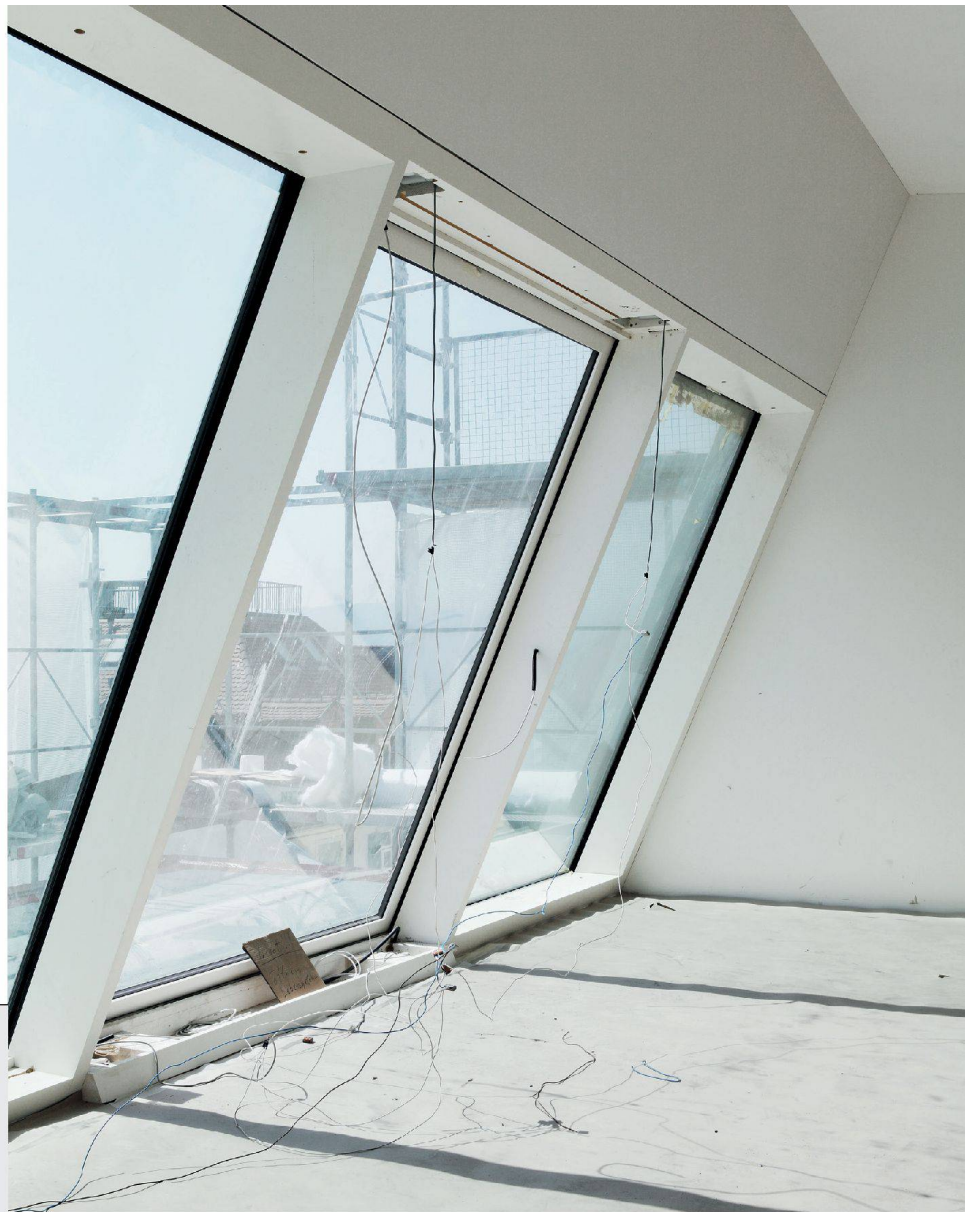
^Konstruktions-Meisterstück: Schrägliegende Schiebefenster im Attikageschoss.
