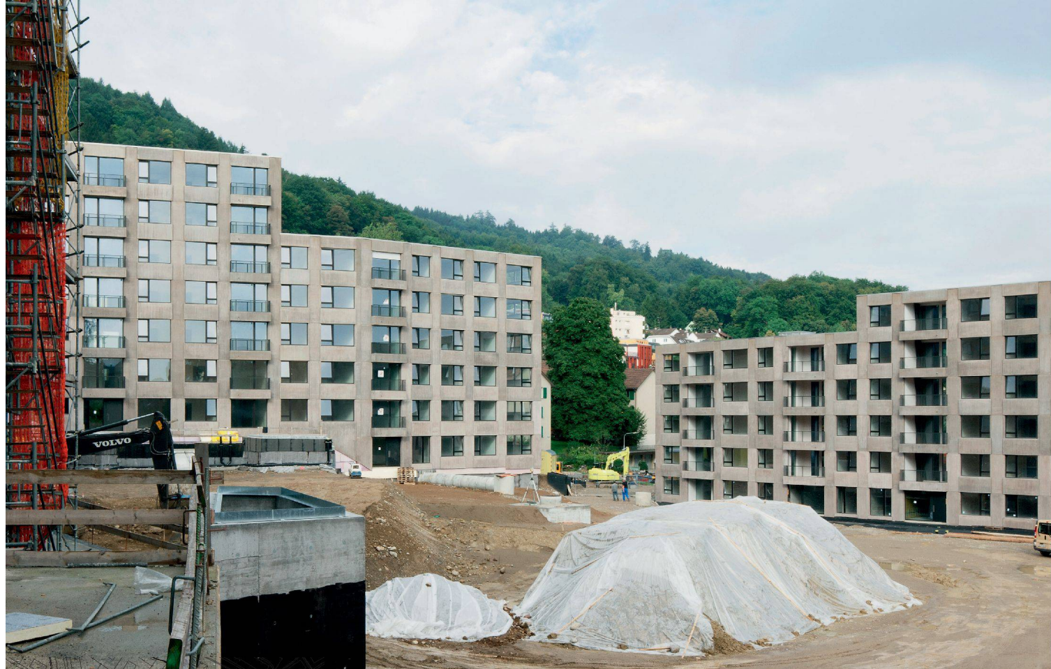
^1_Der grosse Hof der neuen Überbauung, noch unbegrünt.
