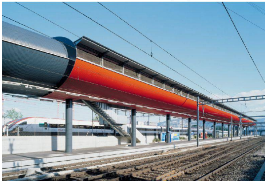
✓4_S-Bahn-Station «Genève-Sécheron»: Die rote Röhre ist auch ein Veloparkplatz.
