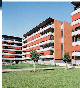
✓35_Wohnüberbauung «Les Marbriers».
