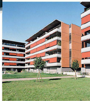
◀35_Wohnüberbauung «Les Marbriers».
