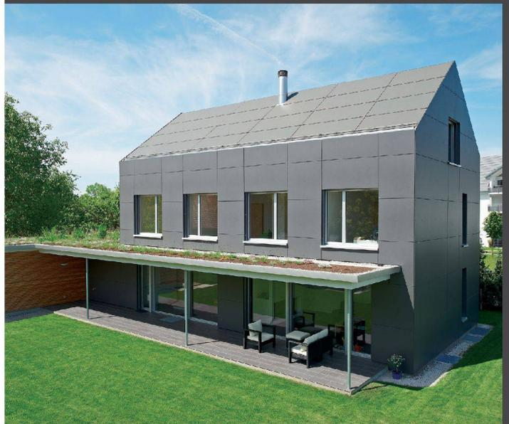
Dachgestaltung, die durch ihre zurückhaltende, flächige Wirkung überzeugt. INTEGRAL PLAN ist bereits ab einer Dachneigung von 6° möglich.
