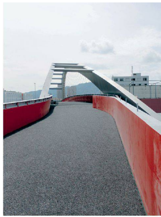
◀ Eine Passerelle überspannt die von Autos und dem neuen Tram befahrene Pflingstweidstrasse.
