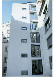
<4_Geschäftshaus Blumenbergplatz, Attikageschoss.
