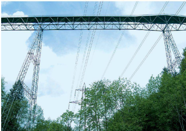
✓64_Haggenbrücke, die «Gangelibrigg».
