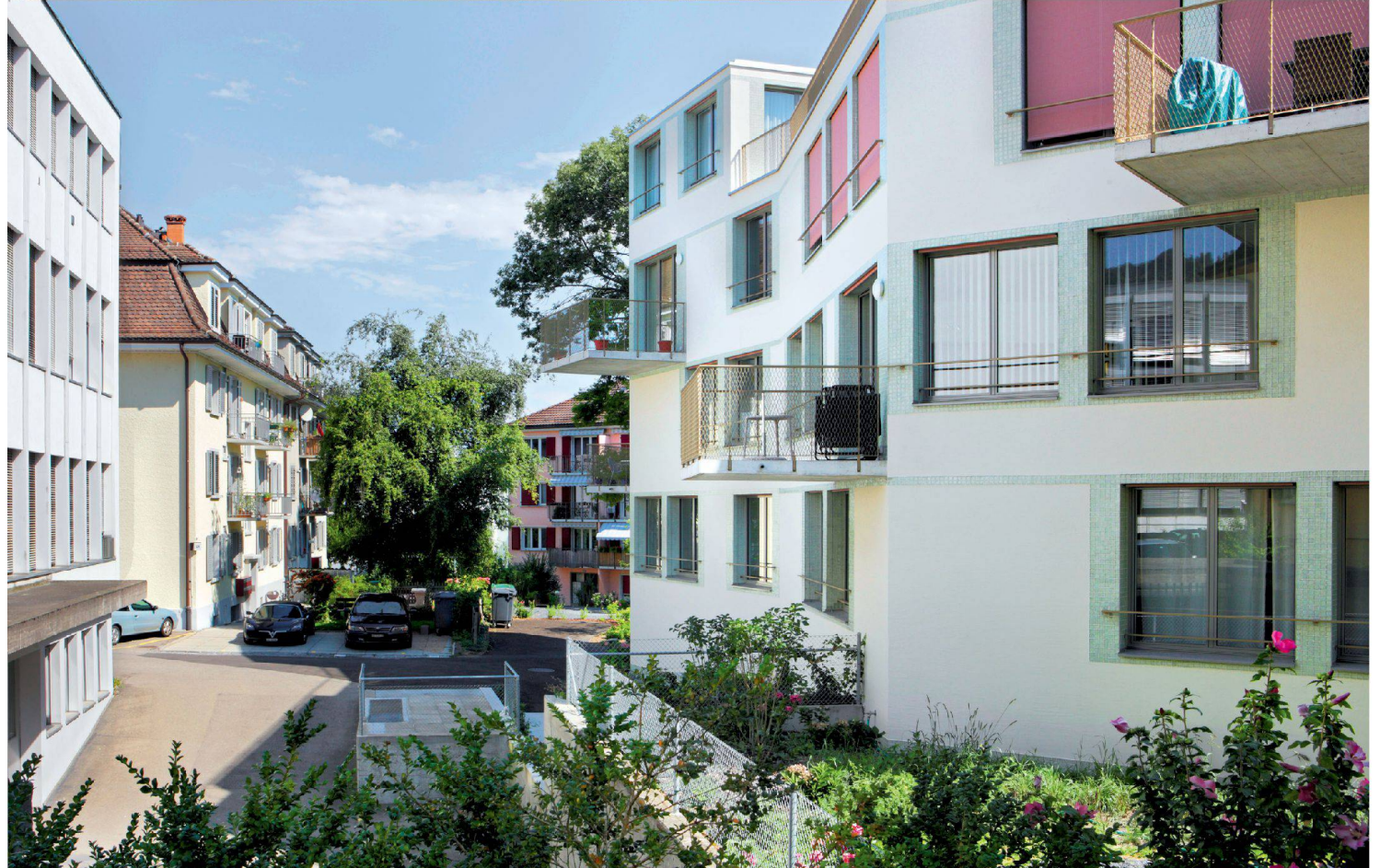
^In einem Hinterhof in Zürich-Binz streckt sich das Wohnhaus nach allen Seiten.
