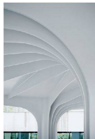
^ Stütze und Rippe fließen nahtlos ineinander über.
