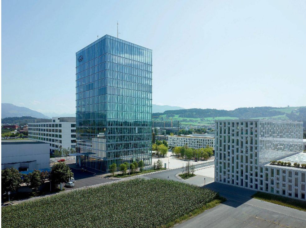
^Komponiertes Industrieareal in Rotkreuz: Mit den weissen Bauten von Scheitlin Syfrig rahmt das Glashochhaus von Burckhardt+Partner einen weiten Platz.
