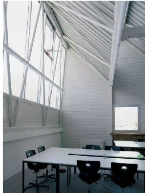
^ Die Schulzimmer werden durch Sheddächer erhellt, hier geniessen die Lehrlinge aber auch einen weiten Ausblick über die Magadinoebene.
